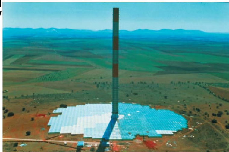
Abbildung 3 Prototyp für ein Aufwindkraftwerk in Manzanares Spanien
