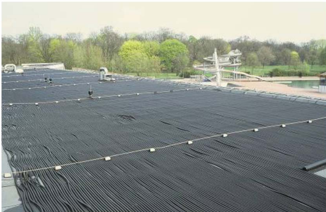
Abb. 1: Unverglaster Kollektor im Freibad in Berlin-Pankow Source: DGS
